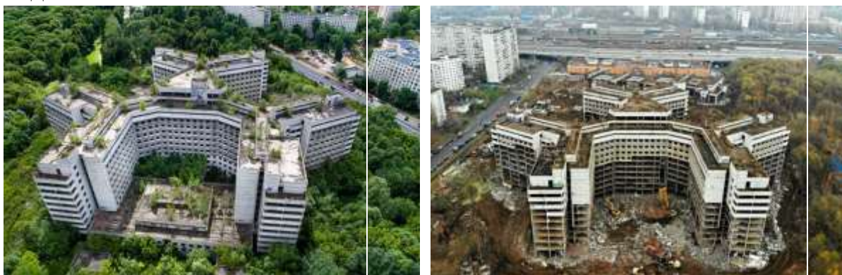
а) общий вид недостроенного объекта
