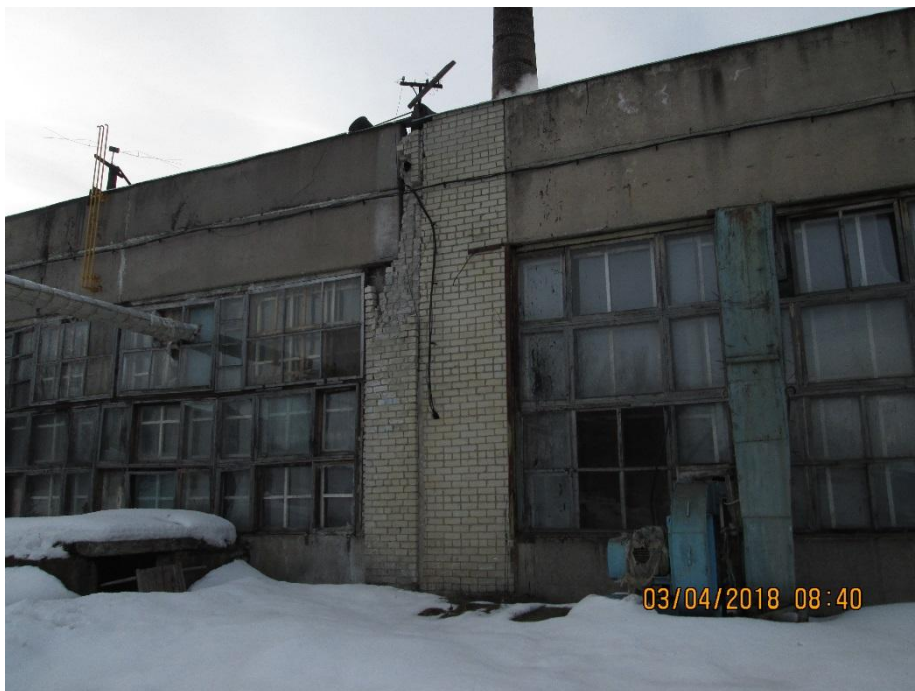
Фото 2. Здание котельной №1 р. п. Ишеевка, ул. Гагарина, 24.
