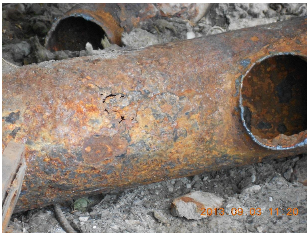
Рис. 4. Демонтированный участок тепловой сети котельной №2 р.п. Ишеевка
