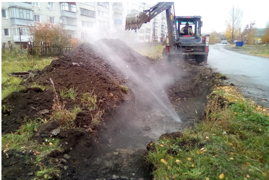
Фото 5. Аварийные работы по устранению порыва теплотрассы. Р. п. Ишеевка, октябрь 2019 г.
