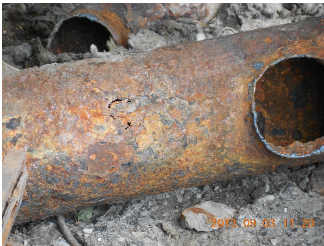
Фото 4. Демонтированный участок тепловой сети котельной №2 р.п. Ишеевка
