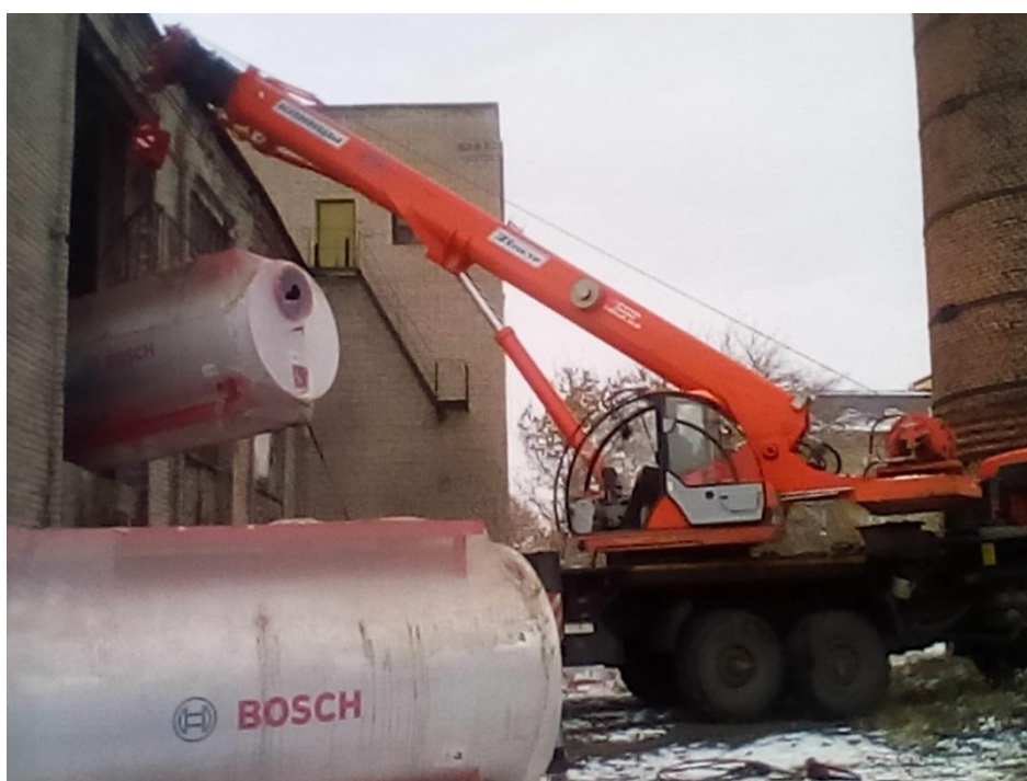
Рис. 3 . Частичная модернизация котельной №2, ул. Ульянова, 1П, ноябрь 2017 г.
