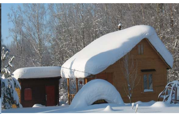
Рисунок 2 – Отсутствие наледей на крыше неотапливаемого дачного дома
