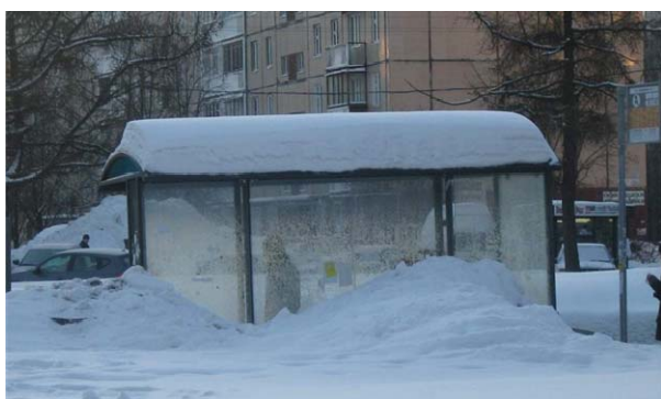
Рисунок 1 – Крыша открытого павильона остановки общественного транспорта
