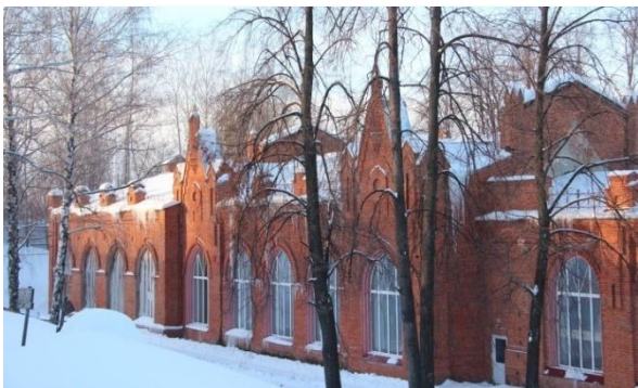
Здание водозабора на р. Свяга, 1911-1913 гг.
